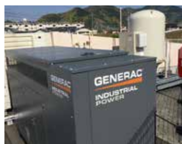
屋上に設置した 災害バルク貯槽と発電機
