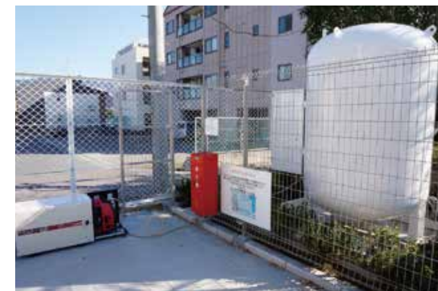
災害バルク貯槽と接続した可搬式発電機
