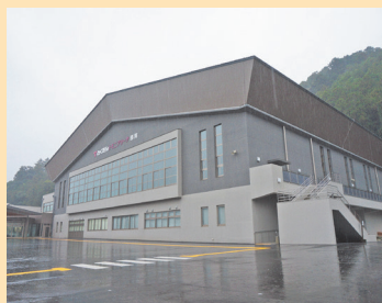
那賀町総合体育館
